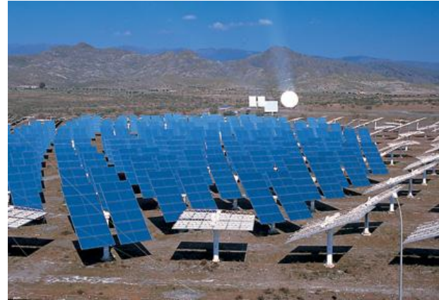
Central solar: painéis fotovoltaicos.
