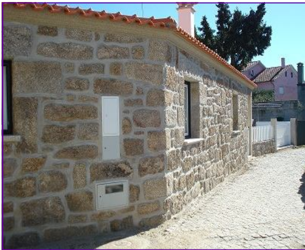
O antes e o depois de uma casa recuperada na freguesia de Decermilo, em Sátão.
