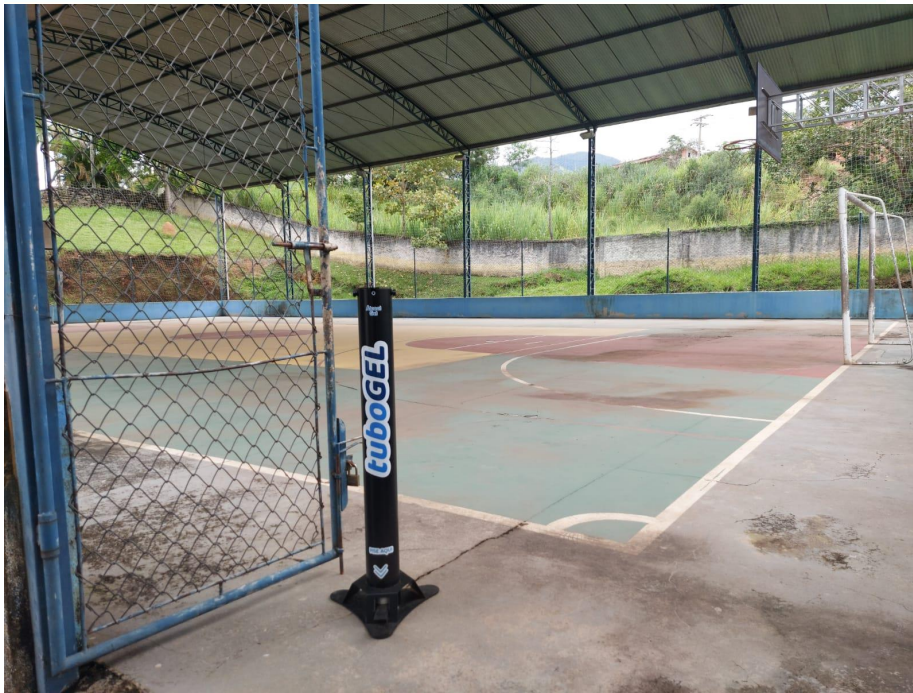
QUADRA COBERTA PARA ATIVIDADES FÍSICAS
