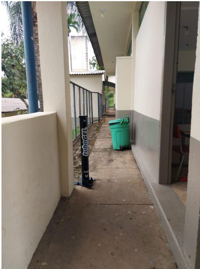
CORREDOR PARTE SUPERIOR DESTA UNIDADE ESCOLAR
