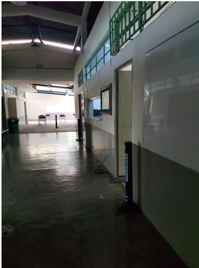
CORREDOR PRINCIPAL DA UNIDADE ESCOLAR
