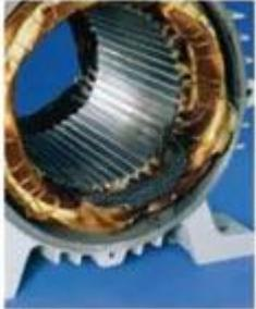
**BOBINA CURTO-CIRCUITADA:** Contaminação interna do motor; Falha do esmalte de isolamento do fio; Falha do verniz de impregnação; Rápidas oscilações na tensão de alimentação.
