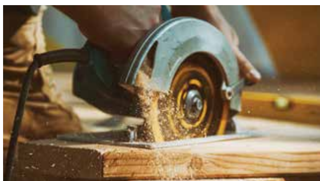
Trabalhos em Madeira
