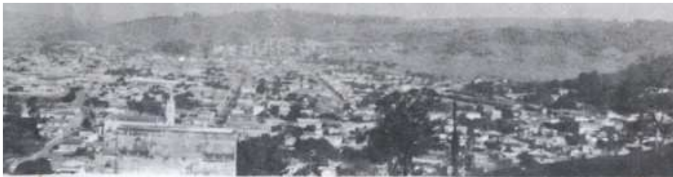
Vista parcial da cidade de Pedro Leopoldo - Minas Gerais.
