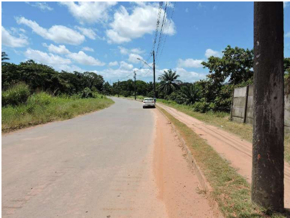
VISTA PARCIAL EXTERNA DA GLEBA AVALIANDO – MATRÍCULA 62.893 DETALHE PARA A VIA MARGINAL DA AVENIDA 29 DE MARÇO SENTIDO ALPHAVILLE II
