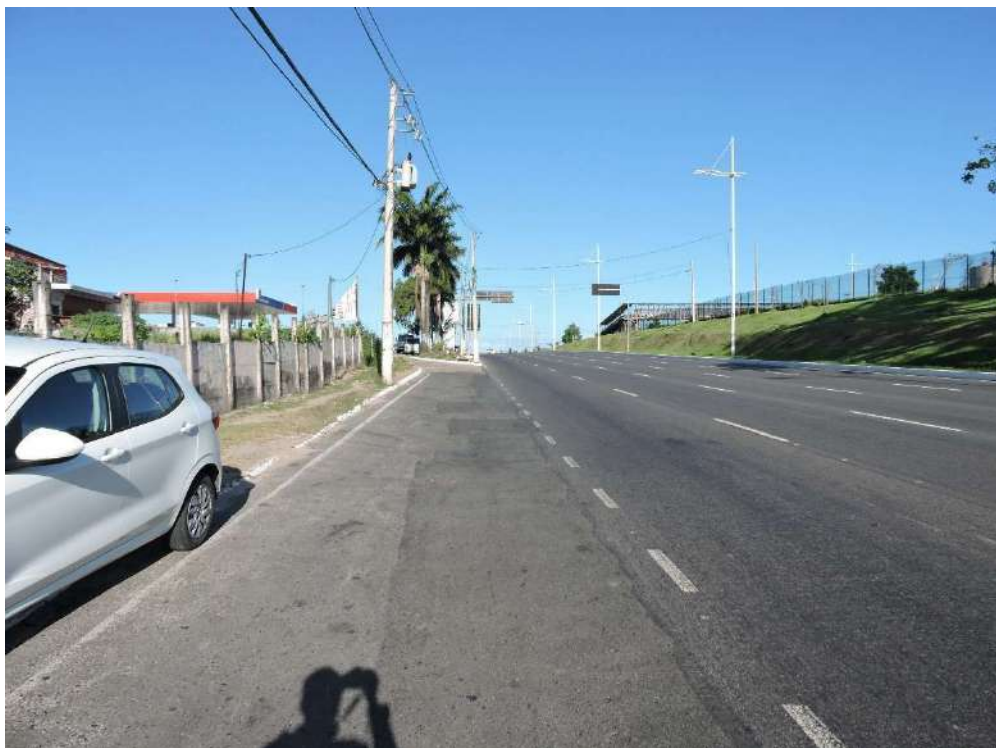
VISTA PARCIAL AV LUIS VIANA SENTIDO MUSSURUNGA I
