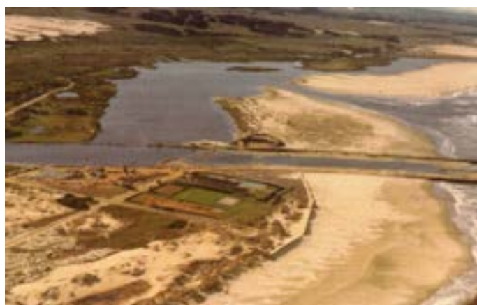
Obra dos Molhes do Mampituba
